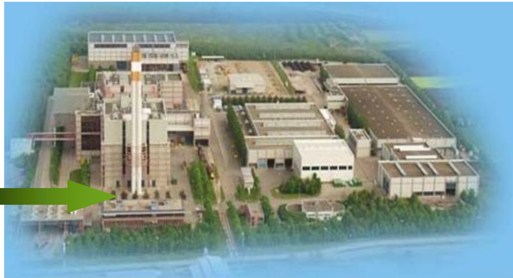
Центр по переработке отходов в Аугсбурге для сжигания бытового мусора и специальных отходов
