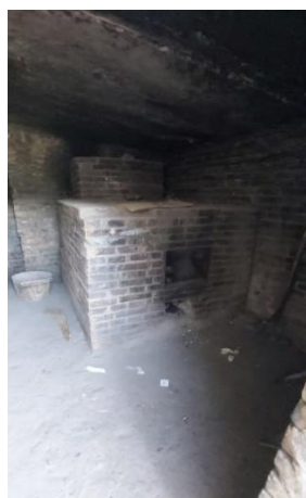
Фотография 40. Печь для сжигания МО в РЦЗ Мастчох
