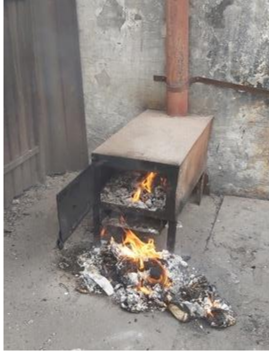
Фотография 2. Мусоросжигательная печь в городском ЦИП г. Бохтар
