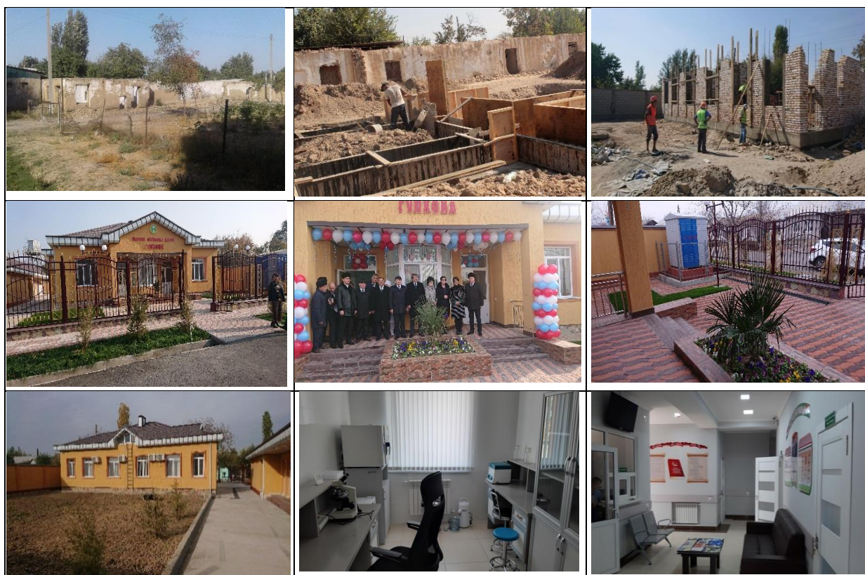
СЦЗ «Хитойкишлок». Кредит: 5666-Т/Т. Здание 1-этажное, Тип А.
